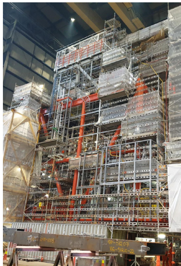
SEP-modulen i Nordsjøhallen skal være mekanisk ferdigstilt 1. februar 2020.
